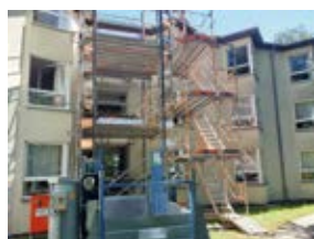
Schaffung eines extra Bauaufgangs
