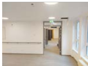
Neue Türen in den Wohnbereichen
