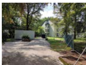
Am Anfang: Eine Zufahrt wird geschaffen
